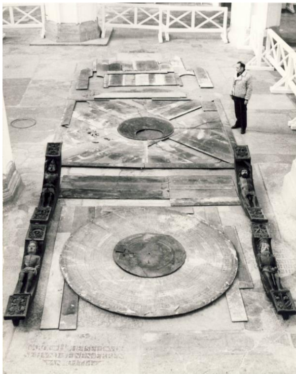
Abb. 3: Uhrfassade auf dem Kirchenfußboden zerlegt (1985). Fasada zegara rozłożona na posadzce kościoła w 1985 r.
